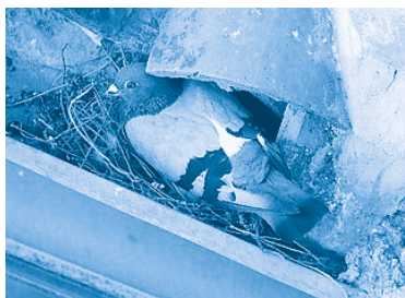
Figura 3. Nido de paloma en el desagüe de un tejado. (Imagen obtenida en: www.blogspot.com . Accedido 7 de noviembre de 2007).
